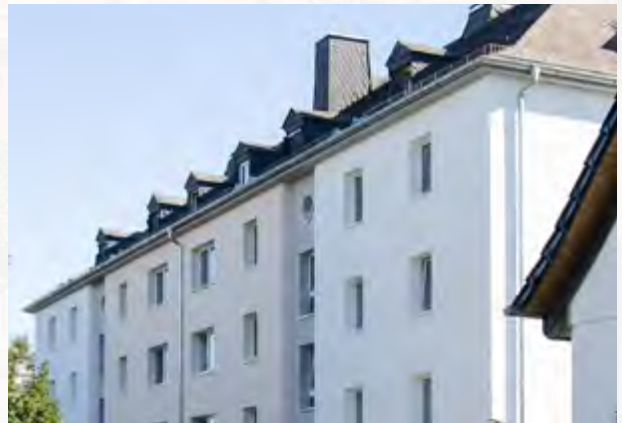
Wetzlar, Magdalenenhäuser Weg (ICD 7 R+)
