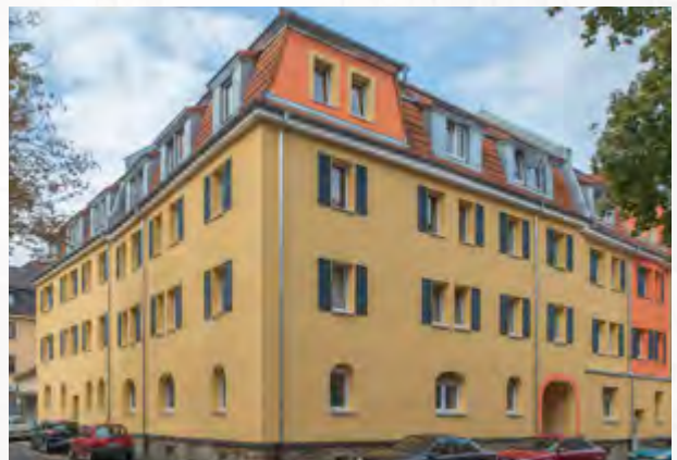
Schweinfurt, Gabelsbergerstraße/Seestraße/Wilhelmstraße (ICD 5 R+)
