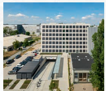
Tiefgarageneinfahrt des Anlageobjekts
