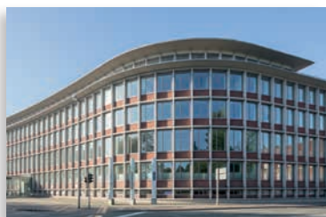
Denkmal Münster Hauptmieter: Multi-Tenant Gesamtinvestition: 22,71 Mio. Euro
